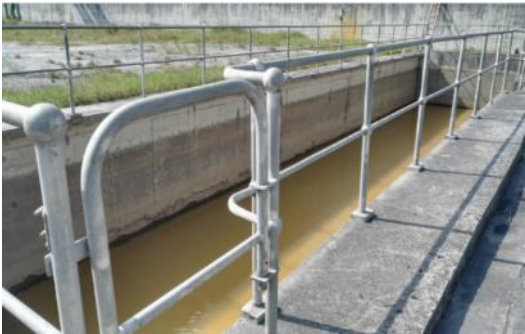
码头煤泥沉淀池
