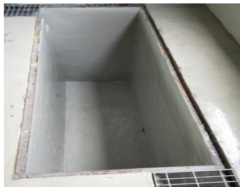
图 10 危废房收集池防腐防渗
