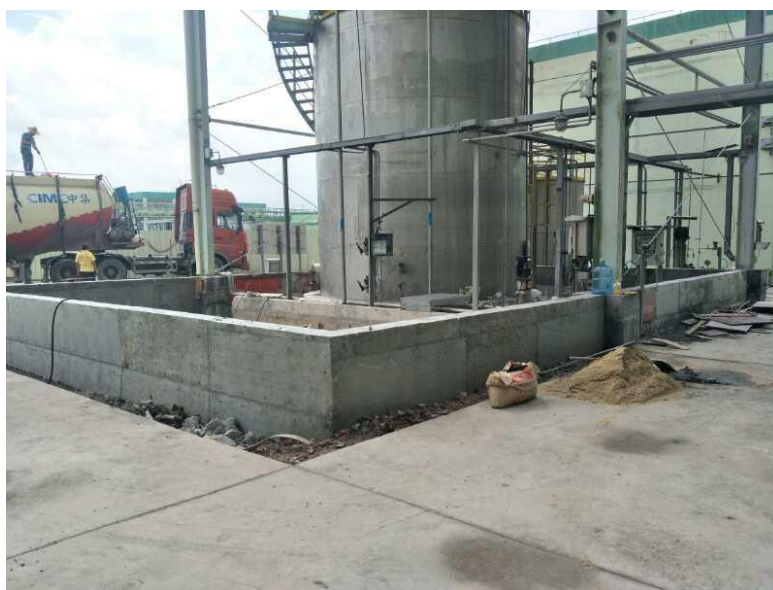
图 21 氨水储罐扩建围堰
