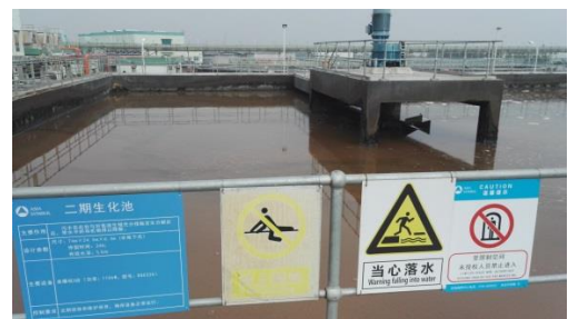
照片 6 二期生化池
